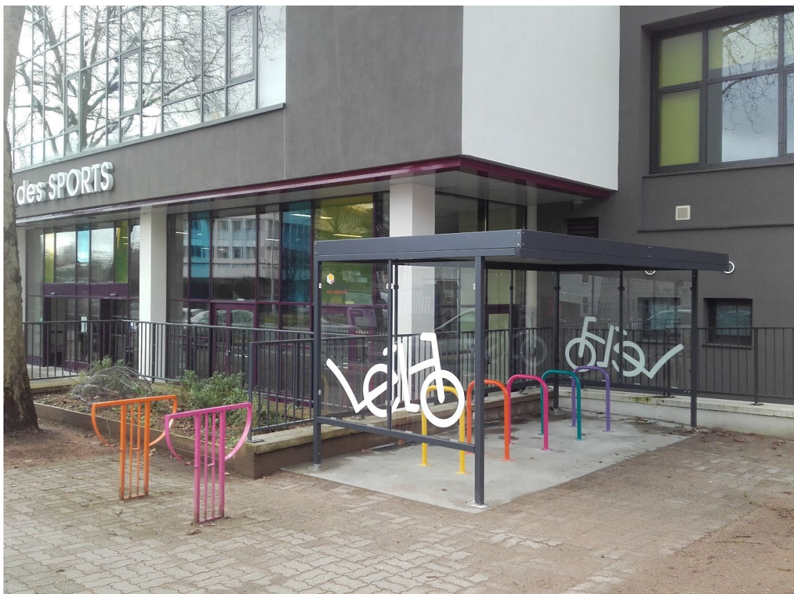
Abri vélo extérieur accessible au public de la Maison des Sports de Nevers
